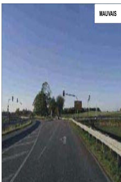
Figure 5 : Jonction, perceptible seulement 100 m avant : freinage inattendu et vitesse trop élevée à ce point causent des accidents [16]
