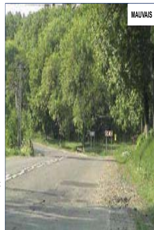
Figure 8 : Le tracé du virage n'est pas perceptible car la courbe intérieure est cachée : freinage inattendu, coups de volant et vitesse trop élevée causent des accidents [23]
