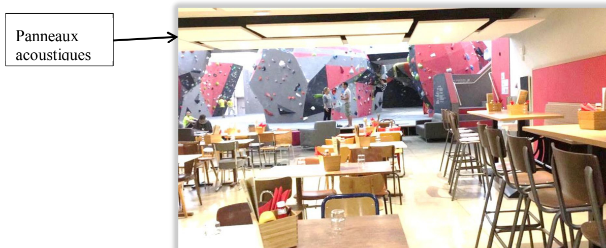
Figure 4-7 : Illustration des panneaux acoustiques de la salle Block'Out de Toulouse
